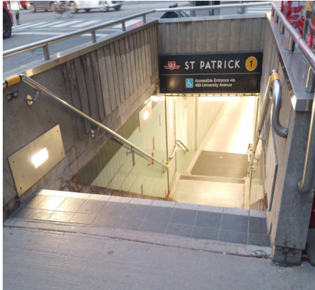
Figura 1: Estação para o metrô.
